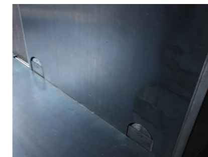
Rueda para puerta corredera de acero RCR Arquitectes. Espai Barberi © RCR Arquitectes
