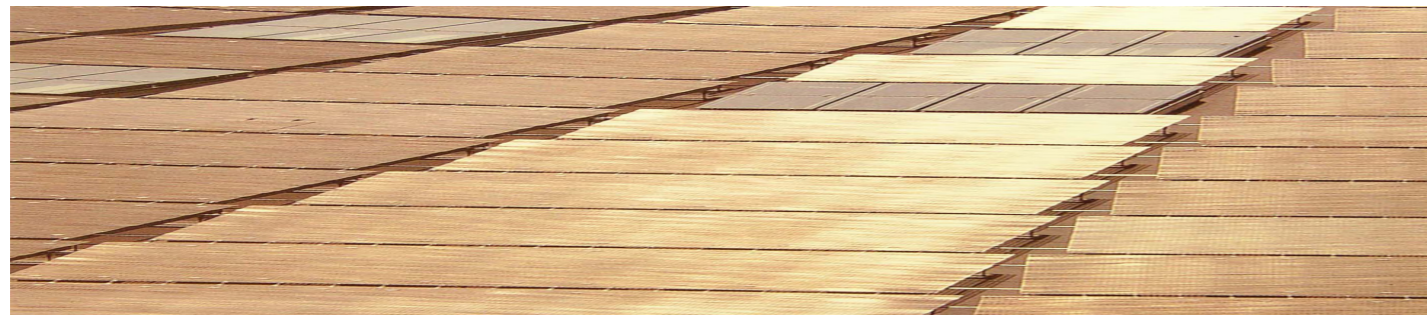
Cubierta plana de malla de acero - Dominique Perrault. Velódromo y piscina olímpica en Berlín © Hisao Suzuki
